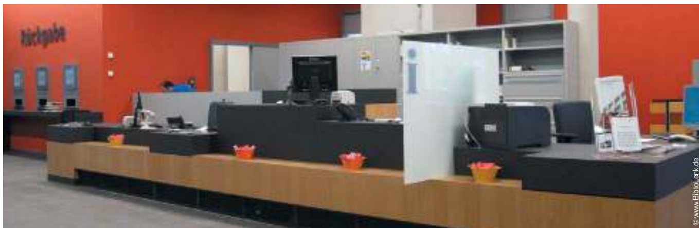
Erdgeschoss: Thekenanlage höhenverstellbar, Linoleum auf Gehrung mit Furnier-Front Eiche
