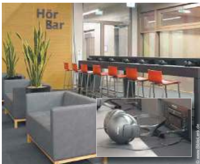
1. Obergeschoss: HörBar, Verbundplatten Linoleum, vierseitige Gehrung, 5 Meter freitragend
